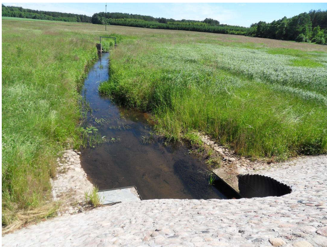
Fot. 9.11. Przecięcie dw 685 z ciekim Małynka (istniejący przepust z półkami dla zwierząt).
